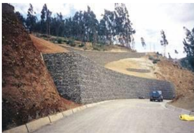
Figura 3) Gabião Tipo Caixa
